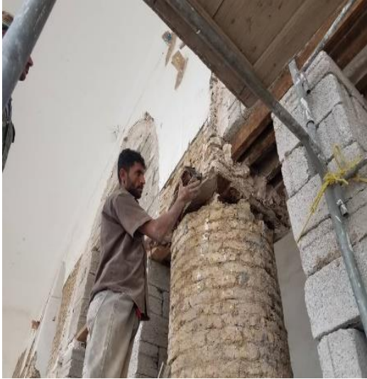
الشكل ٤٥: أعمال الترميم بإزالة الفرشاة الخشبية التالفة واستبدالها بأخرى جديدة ومن نفس نوع مادة الخشب
